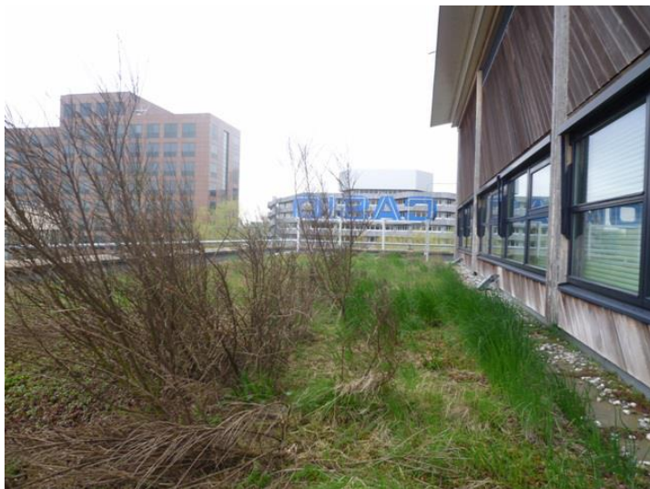
FIGUUR 3 BIJ GEBREK AAN ONDERHOUD KRIJGEN, INDIEN DE STANDPLAATSOMSTANDIGHEDEN GESCHIKT ZIJN, HOUTIGE PLANTENSOORTEN DE KANS ZICH TE VESTIGEN OP HET GROENDAK, MET SCHADE AAN DE ONDERCONSTRUCTIE TOT GEVOLG (BRON: BENROOS.NL)
