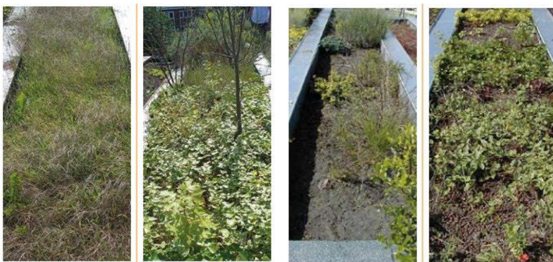
FIGUUR 6 EVOLUTIE IN BEPLANTING OP TWEE EXPERIMENTELE GROENDAKEN NA TIEN JAAR TIJD. LINKS: 2003; RECHTS: 2014 (BRON: WTCB)
